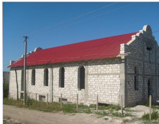
Der Bau des neuen Gemeindehauses in Resenj
